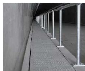
トンネルダクト
