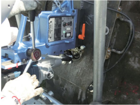
アンカーテンドン切削状況
