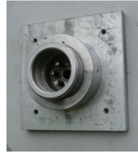
特殊定着具の設置状況
